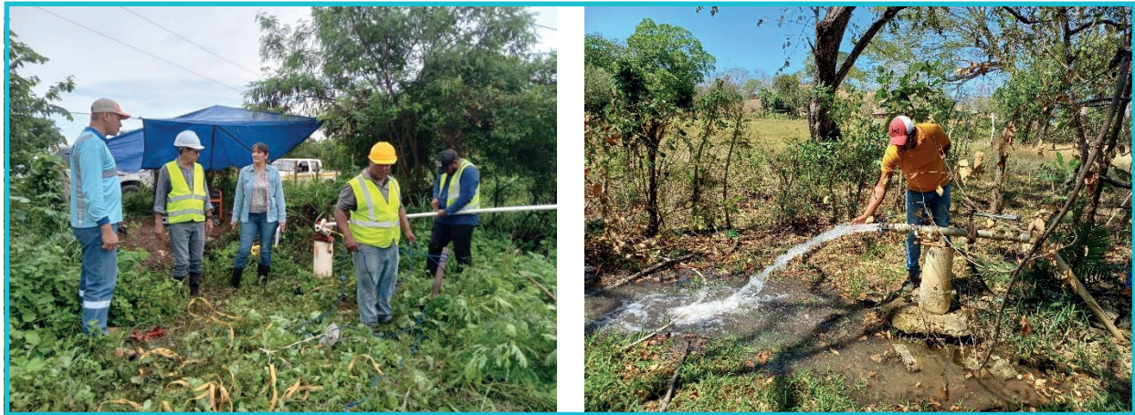
Figura 17. Monitoreo de caudales y respuesta hidráulica de pozos existentes.
